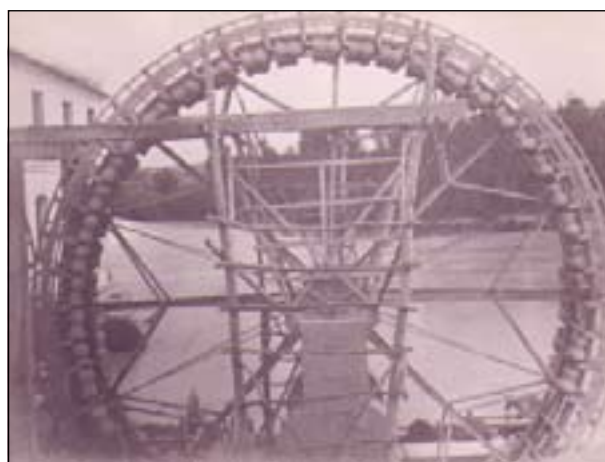
Fig. 3. Esquema de las partes integrantes de una noria tradicional de madera y fotografía de una noria de componentes de hierro situada junto a la Electroharinera de Palma del Río.
