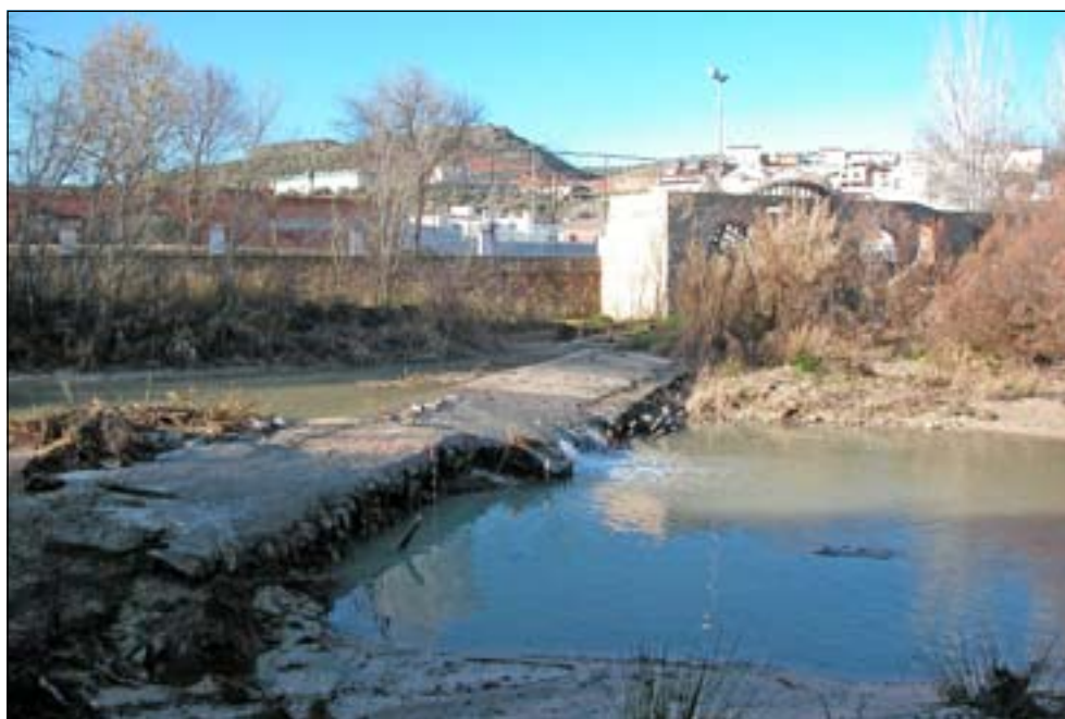
Fig. 1. Presa de deriva tradicional situada sobre el río Guadajoz junto a la noria de Albendín, en término municipal de Baena (fot. R. Córdoba).
