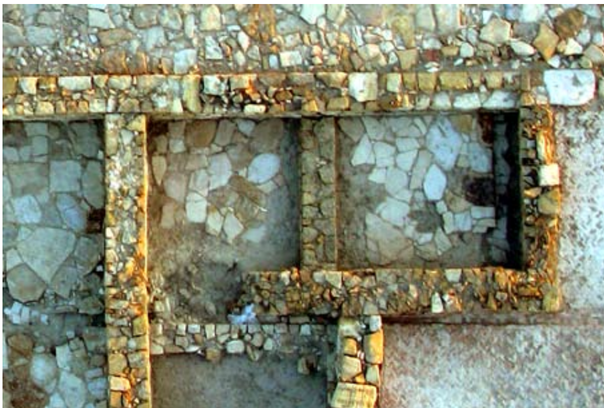
Vista aérea de los espacios E-2 y E-15.
