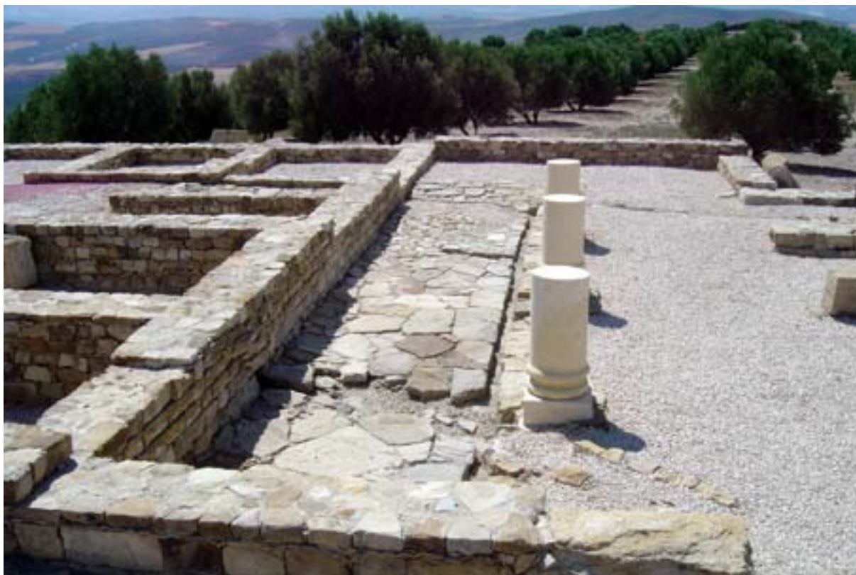
El lado oeste del pórtico tras la restauración.
