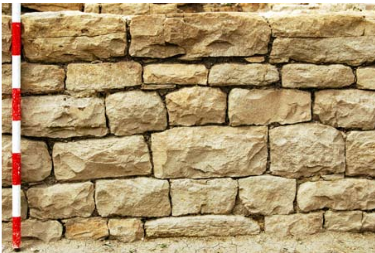
Paramento de opus vittatum del muro de cierre del edificio por el este (U.E. 102).
