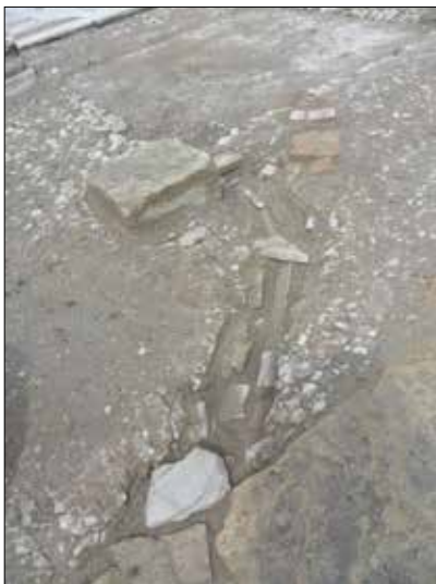
Fig. 9. Canalización aguas pluviales. Fuente: Elaboración propia.
