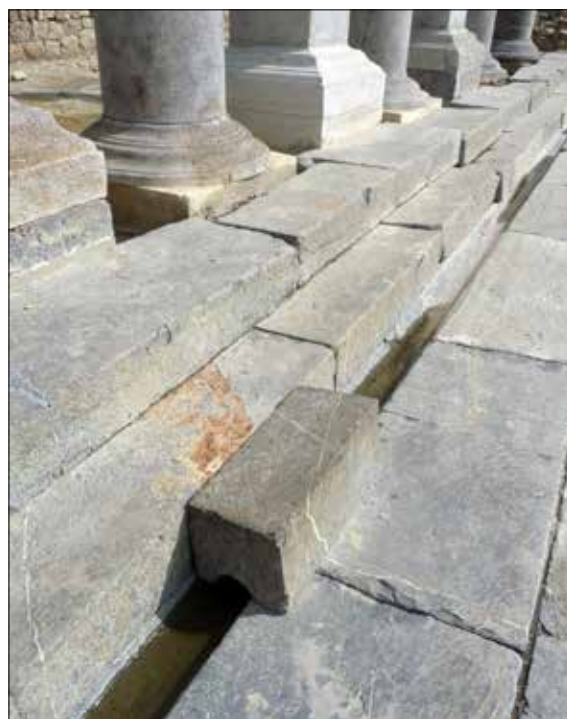
Fig. 93. Detalle del canal perimetral de la plaza forense (Fotografía: C. Pericet).
