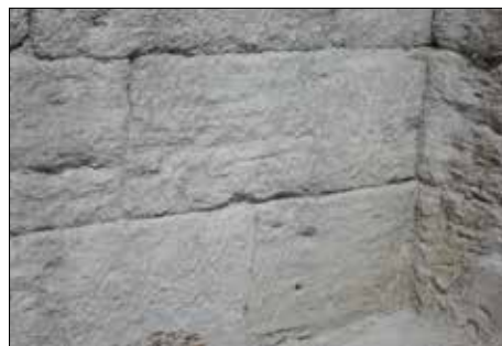
Fig. 18. Opus quadratum. Fuente: Elaboración propia.
