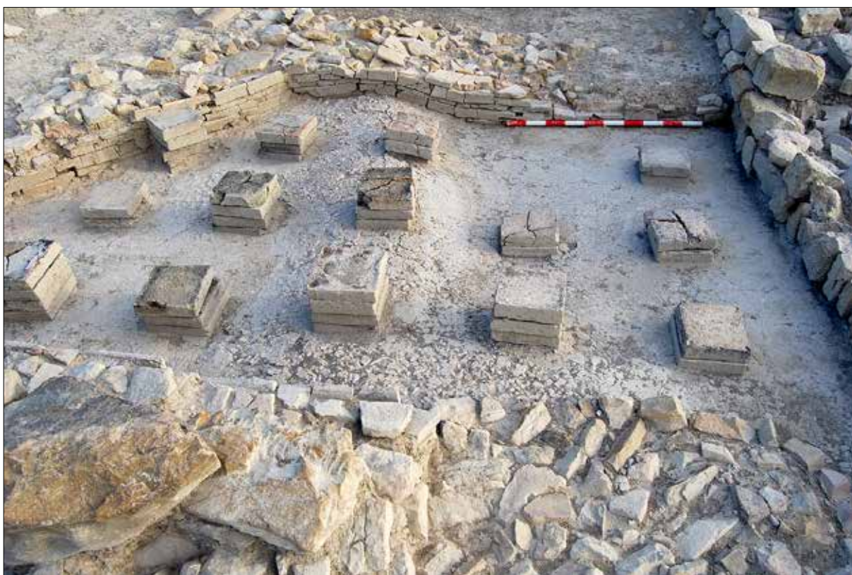
Fig. 21. Fotografía del hypocaustum con suspensurae de la Sala 3 tomada desde el Sur.
