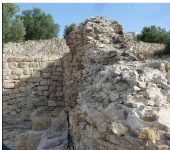
Fig. 45. Detalle de los ladrillos pertenecientes a EST-20 que sobresalen en perfil de EST-18 (Fotografía: C. Pericet).
