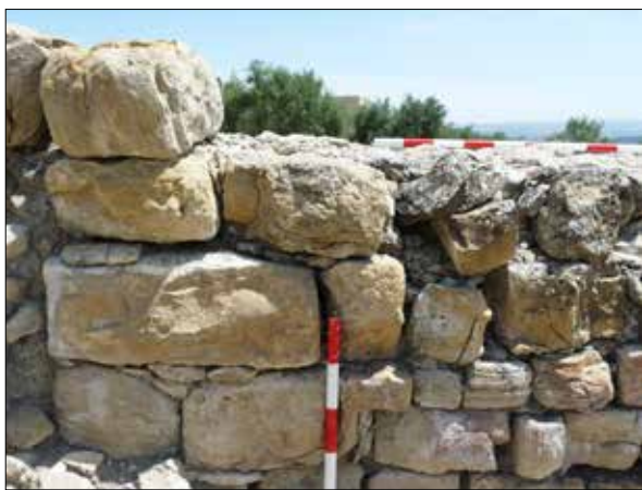
Fig. 21. Detalle de la esquina externa de EST-11, a la que se le adosa un muro posterior (Fotografía: C. Pericet).
