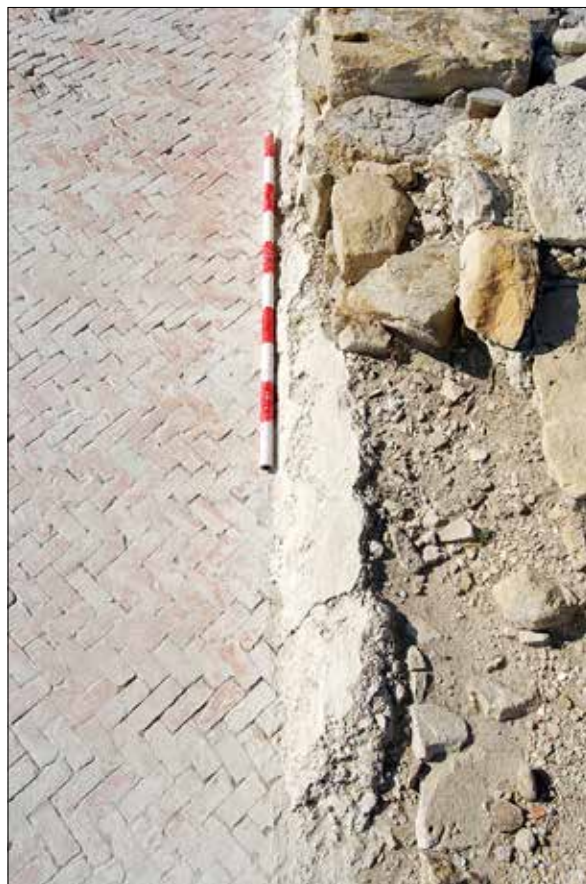
Fig. 13. Fotografía de la zona Norte de la Sala 1, con detalle de la moldura hidráulica de media caña, opus spicatum y el fino muro de mampuestos.
