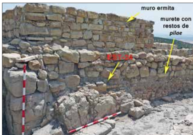
Fig. 55. Detalle del tramo O de EST-23 (Fotografía: C. Pericet).
