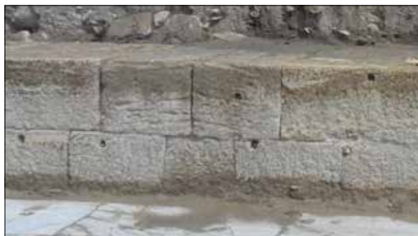
Fig. 24. Taladros para la sujeción del aplacado en los bloques de arenisca. Fuente: Elaboración propia.
