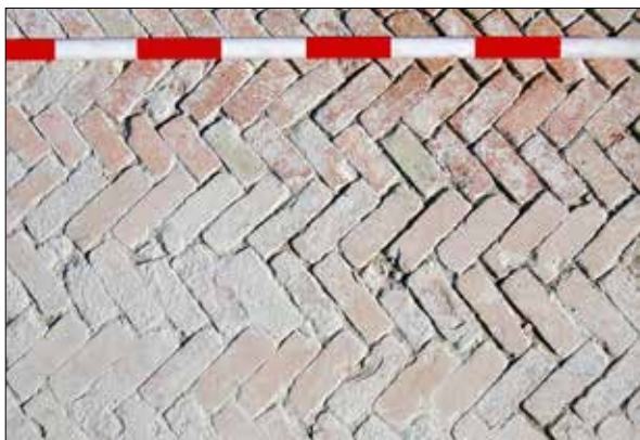
Fig. 12. Fotografía en detalle del pavimento en opus signinum y laterculi de la Sala 1.
