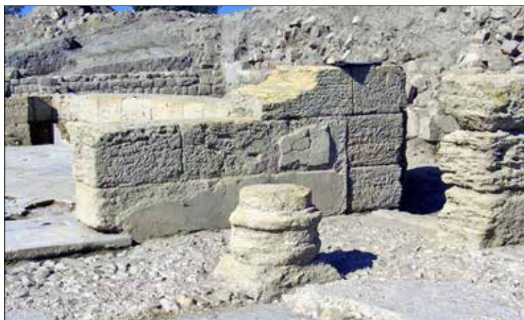
Figura 16. Detalle paramento despiece regular de estuco blanco. Fuente: Elaboración propia.
