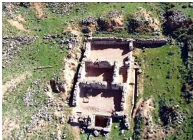
Fig. 42 Vista aérea del estado actual del balneum de Arco-briga (Zaragoza). Extraído de www.turismodezaragoza.es
