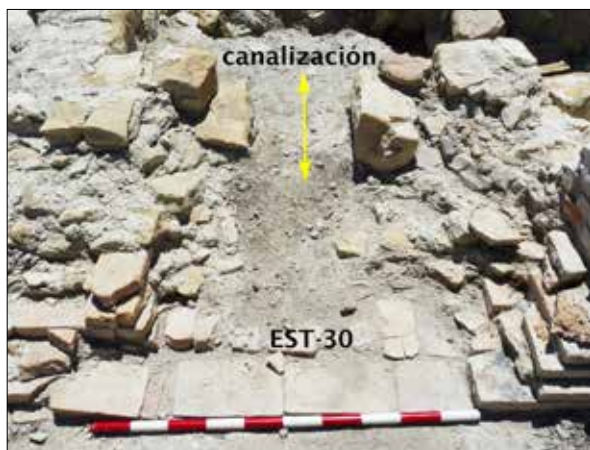
Fig. 73. Canalización del Espacio 4 (Fotografía: C. Pericet).
