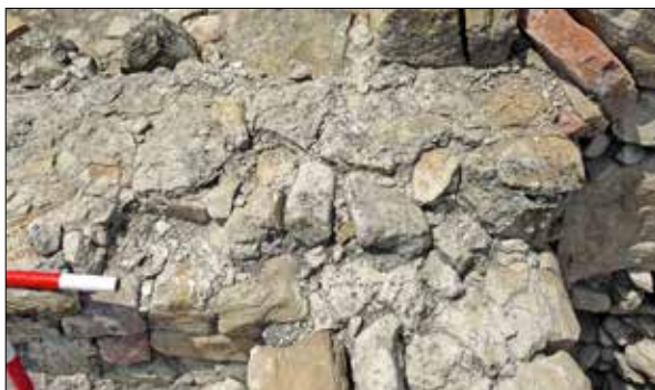
Fig. 20. EST-11, detalle de la unión de los dos muros (Fotografía: C. Pericet).
