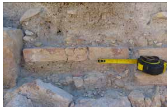
Fig. 56. EST-24, detalle núcleo de ladrillos (Fotografía: C. Pericet).
