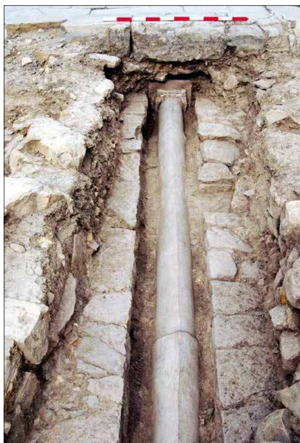
Fig. 35. Detalle de la tubería de plomo para drenaje del Foro. Extraído de MORENA y MORENO, 2010: 436, Fig. 8.
