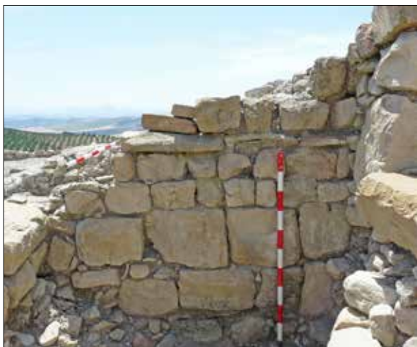
Fig. 43. Detalle alzado careado interno de EST-10 (Fotografía: C. Pericet).
