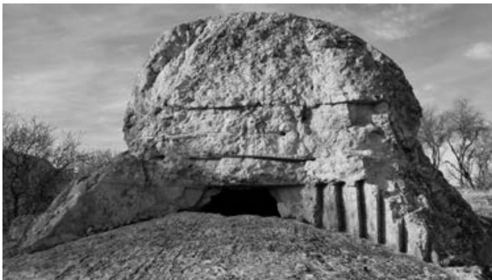
Destrozos causados en el búnker oriental de El Picoso para extraer el metal.
