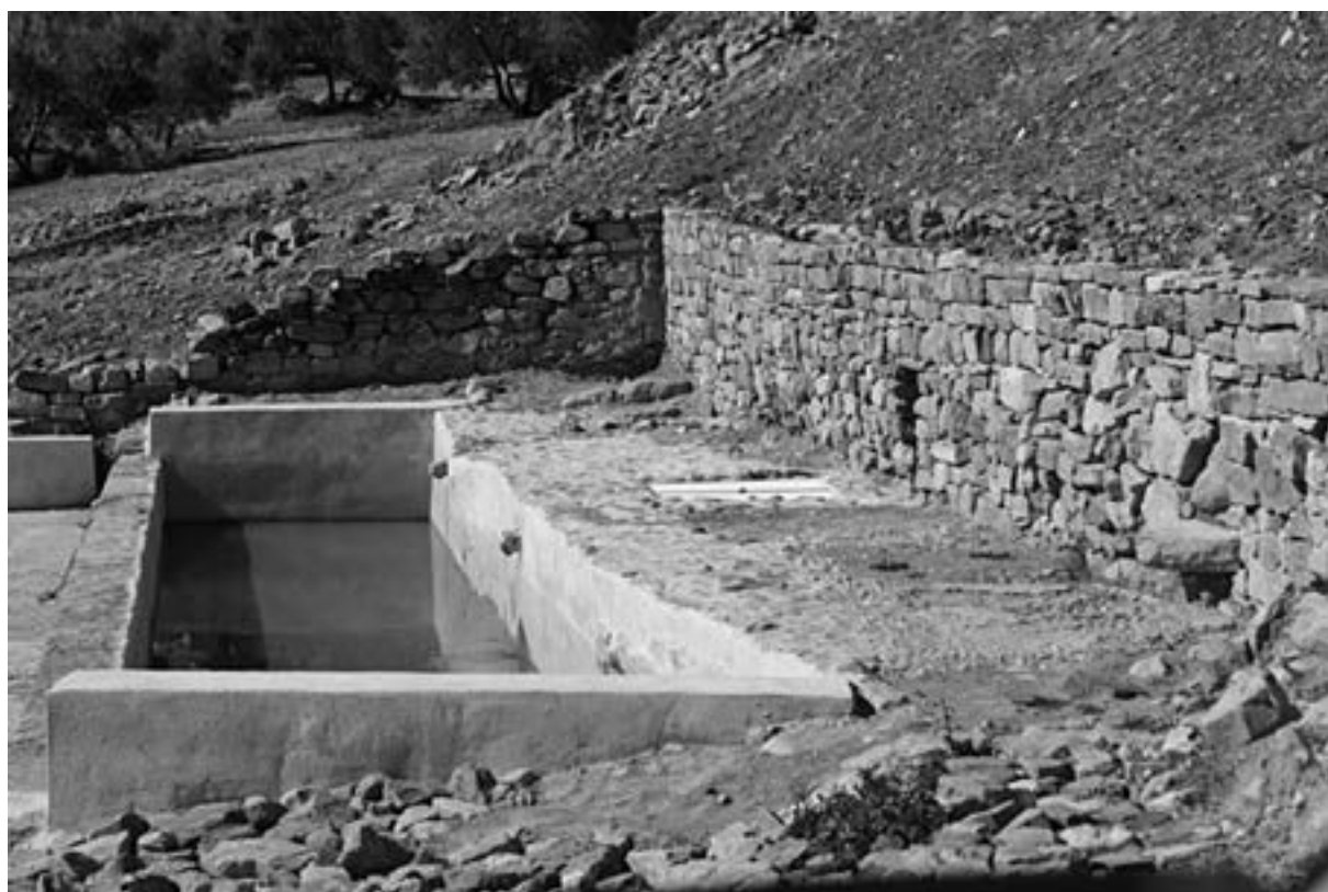
Estado actual de la “Fuente de la Romana” tras la restauración.
