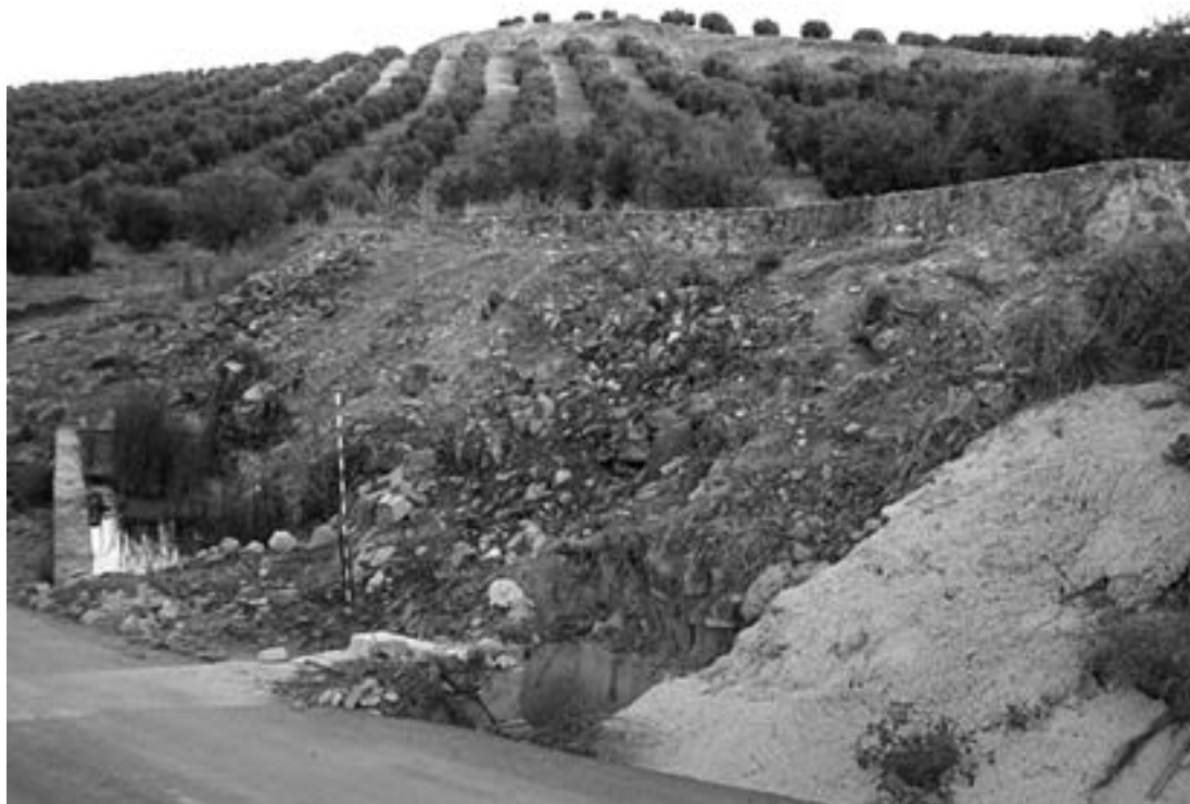
Estado en el que se encontraba la fuente al inicio de la intervención.
