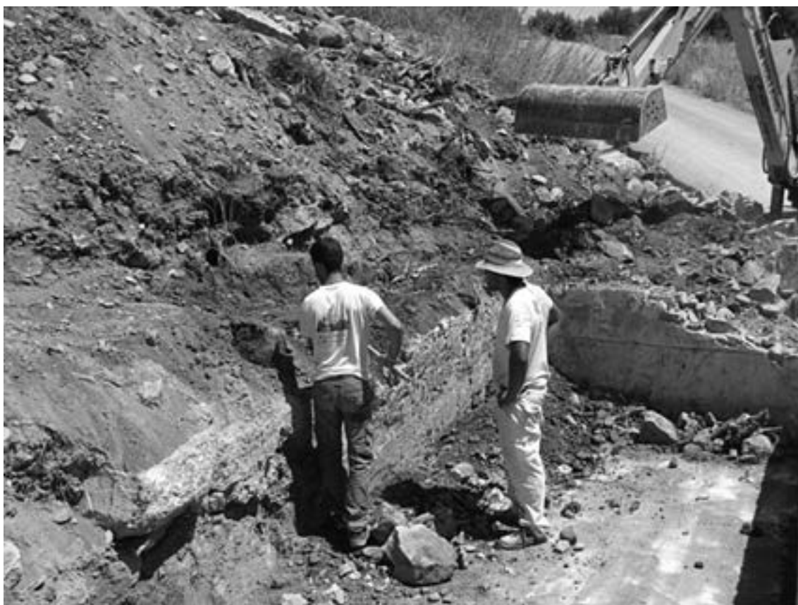
Seguimiento arqueológico en el proceso de retirada de tierra mediante retroexcavadora.
