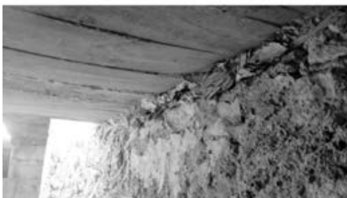
Al lado, un detalle constructivo de la cubierta de uno de los corredores en el que se observan restos de sacos y madera del encofrado.
