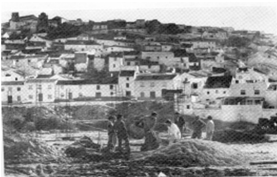
Grupo de voluntarios en el inicio de las obras del Puesto de Socorro. Fuente propia.
