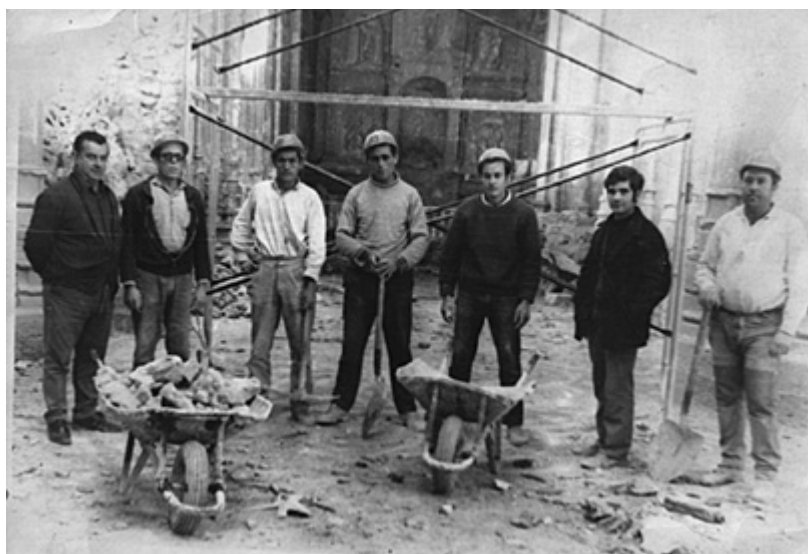
Comienzo de las obras, 4 de febrero de 1970 (Foto: J.A. Gómez-Luengo).
