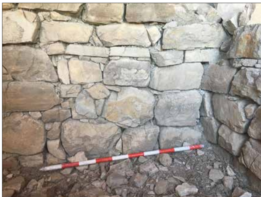
Fig. 37: Aparejo de uno de los muros que conforman cruces internas dentro de las torres.
