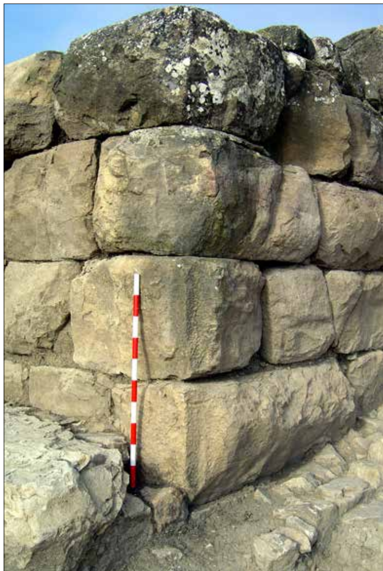
Fig. 33: Detalle de la alineación de los listeles perimetrales en la esquina de la torre norte.
