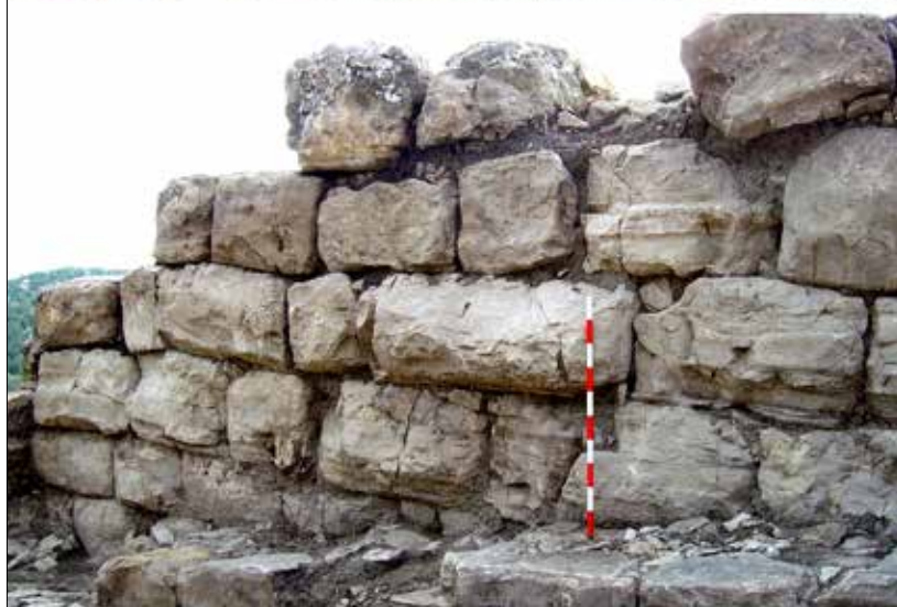
Fig. 32: Aparejo de las fachadas que dan al viario: torre norte (superior) y torre sur (inferior).
