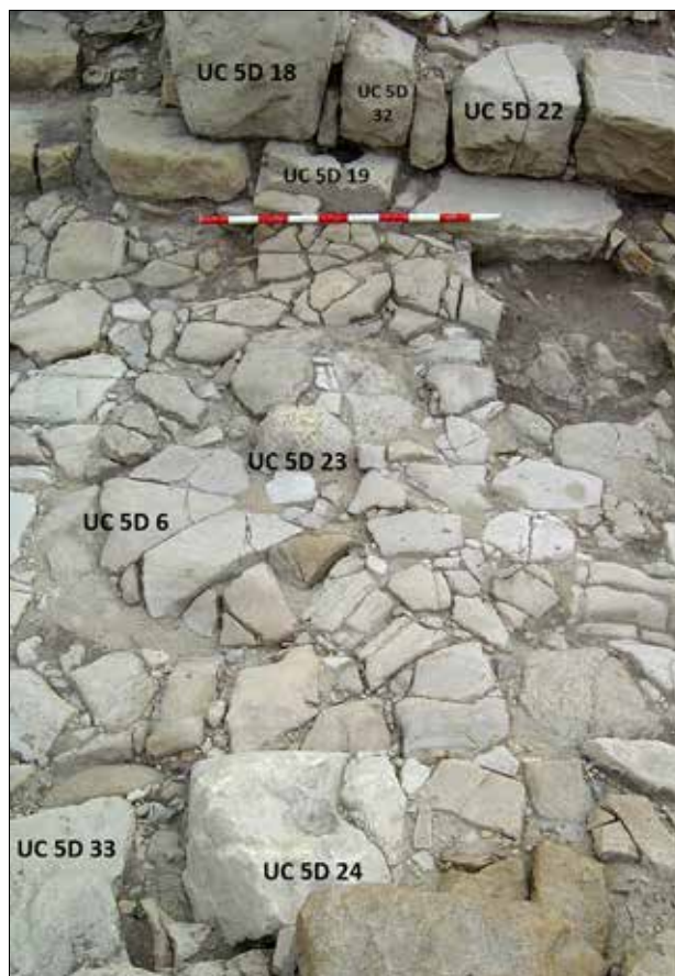
Fig. 21: Elementos que conforman la segunda puerta fotografiados desde el norte.
