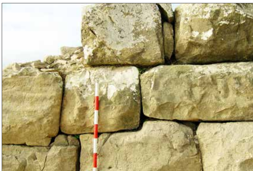
Fig. 34: Detalle de los engatillados, cuñas y ripios en el aparejo de la torre norte.
