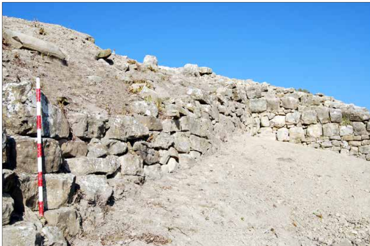
Fig. 9: Paramento externo de la muralla de Torreparedones en el entorno de la Puerta Oriental. Al fondo se aprecia la torre sur de este acceso.
