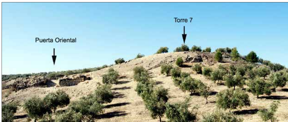
Fig. 41: Puerta oriental de Torreparedones y detalle de la “torre 7”.
