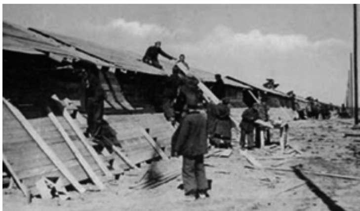
Construcción de barracas en el campo de refugiados de Le Barcarés a mediados de 1939.
