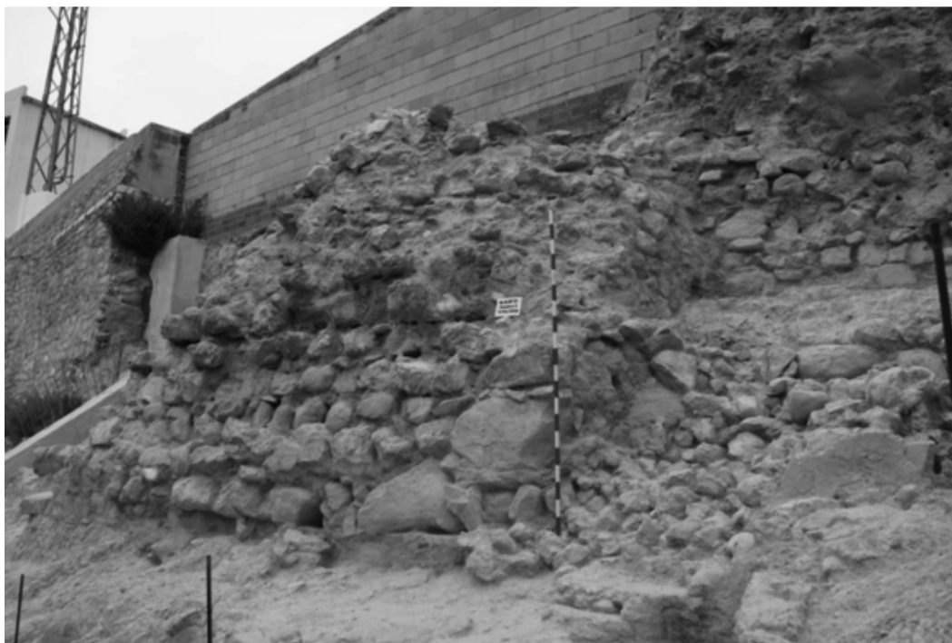
Fase I. Sondeo 2. Vista general desde el SE de la torre una vez excavada. A su derecha restos de vivienda.
