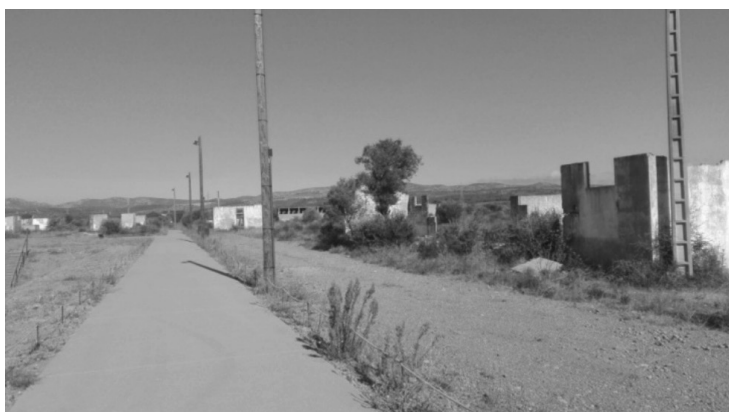
Estado ruinoso del campo de refugiados francés de Rivesaltes en octubre de 2017.
