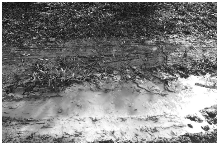
Figura 11. Ejemplo de charco formado sobre una poza convencional por su baja capacidad de infiltrar agua de lluvia debido a la impermeabilización de la misma por la arcilla deposicional. Este efecto no se produciría en las pozas de la Cubierta
