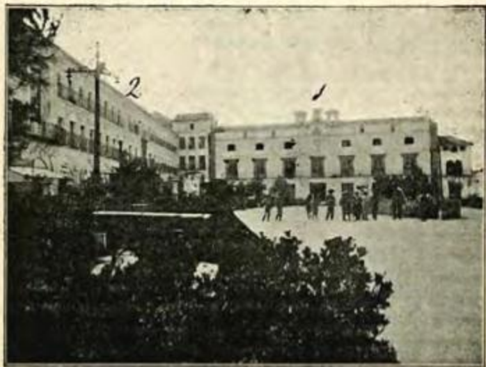
Grabado núm. 17.—1. Casas Consistoriales.—2. Cuartel de la Guardia Civil.
